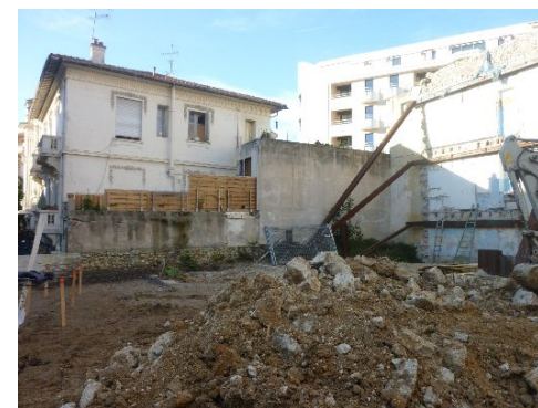
Démarrage des travaux
